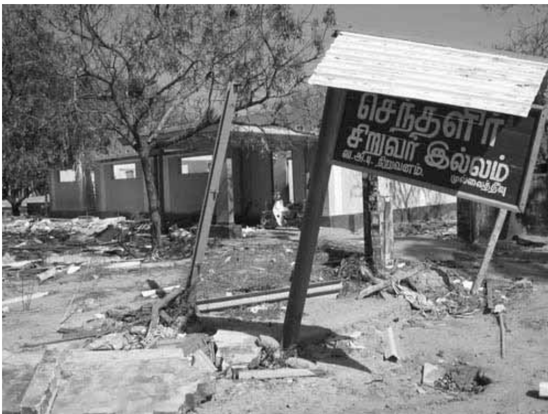
Zerstörtes Waisenhaus (Mullaittivu)
