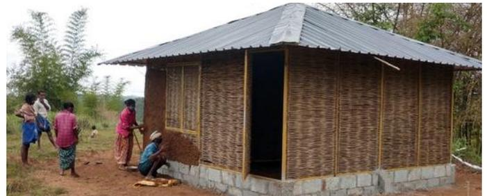
14.3.2. Das neue Haus ist fertig gebaut. Jetzt werden die Wände noch mit Lehm verkleidet.
